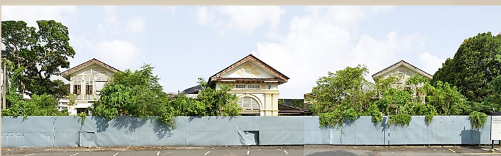
Rumah Rehat Taiping merupakan salah sebuah bangunan Kategori 1 yang terdapat di dalam Zon Warisan Teras Utama dan telah digazetkan di bawah Akta Warisan Kebangsaan 2005
